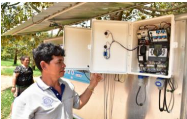
ภาพที่ 4.11 การนำระบบควบคุมการให้น้ำอัตโนมัติในสวนทุเรียนบัวแก้ว
