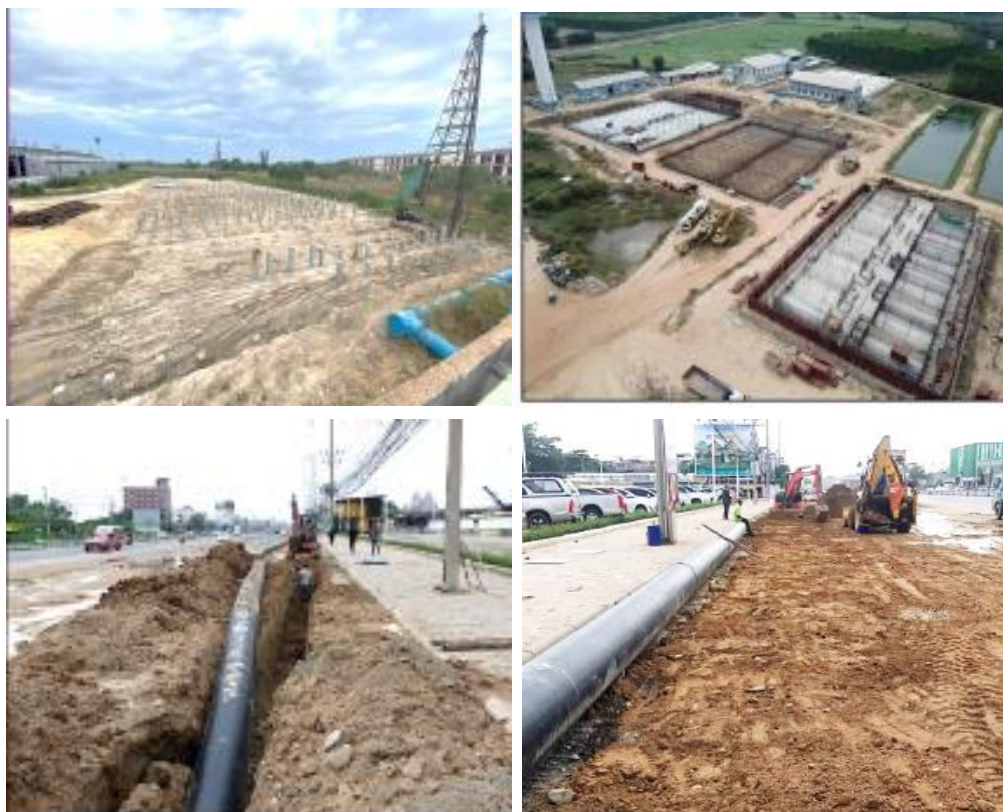
ภาพที่ 1.29 งานก่อสร้างปรับปรุงขยาย กปภ.สาขาชลบุรี-พนัสนิคม-(พานทอง)-(ท่าบุญมี) ระยะที่ 1
