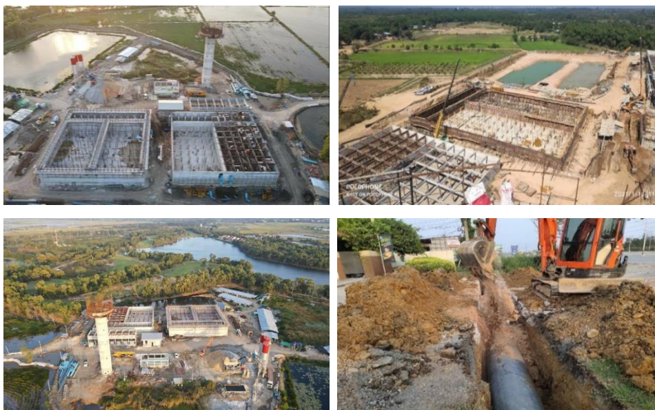
ภาพที่ 1.31 งานก่อสร้างปรับปรุงขยาย กปภ.สาขาพนมสารคาม-บางคล้า-(แปลงยาว)-(คลองนา)-(เทพราช) (รองรับ EEC) อำเภอพนมสารคาม-บางคล้า-แปลงยาว-เมืองฉะเชิงเทรา-บ้านโพธิ์
