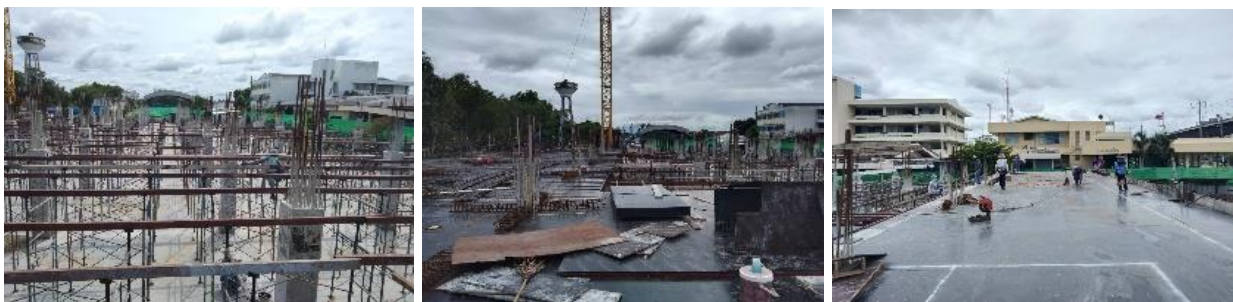
ภาพที่ 5.4 ก่อสร้างอาคารอำนวยการ ผู้ป่วยนอก - อุบัติเหตุ รพ.บางปะกง จ.ฉะเชิงเทรา
