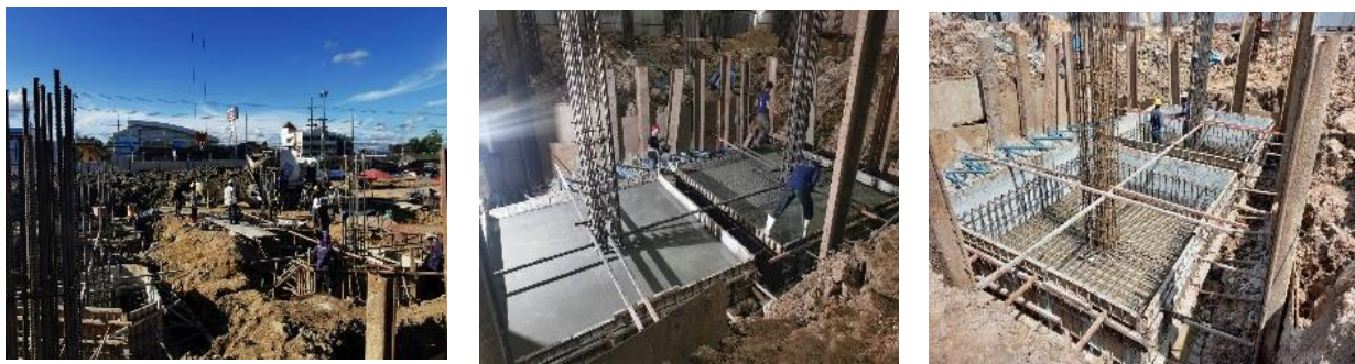
ภาพที่ 5.3 ก่อสร้างอาคารอุบัติเหตุ ผู้ป่วยนอกและผู้ป่วยหนัก รพ.แก่ง จ.ระยอง
