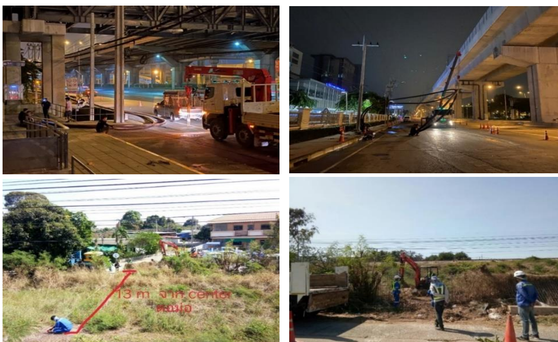
ภาพที่ 1.7 การรื้อย้ายสาธารณูปโภค สำหรับโครงการก่อสร้างรถไฟฟ้าความเร็วสูงเชื่อมสามสนามบิน
