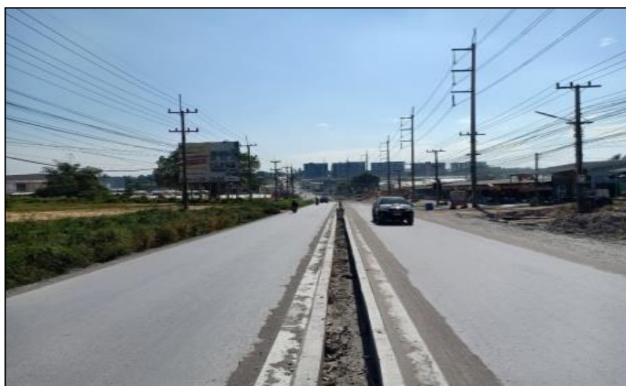
ภาพที่ 1.23 ถนนสาย รย.3013 แยก ทล.331 - ทล.3191 อ.ปลวกแดง จ.ระยอง
