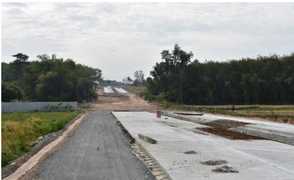
ภาพที่ 1.24 ถนนสาย รย.2015 แยก ทล.36 - ทล.331 อ.ปลวกแดง จ.ระยอง
