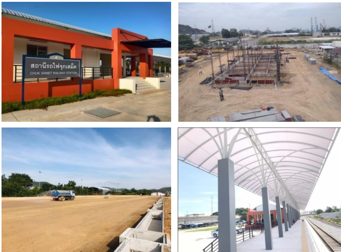
ภาพที่ 2.25 ก่อสร้างสถานีรถไฟจุกเสม็ด
