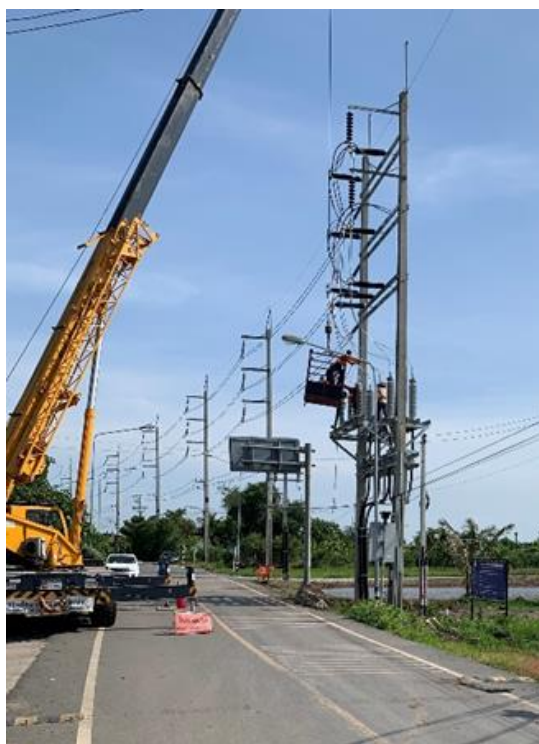
ภาพที่ 1.6 ภาพการเชื่อมสายเคเบิลใต้ดินระบบ 115 เควี บริเวณคลองก้น จ.ฉะเชิงเทรา
