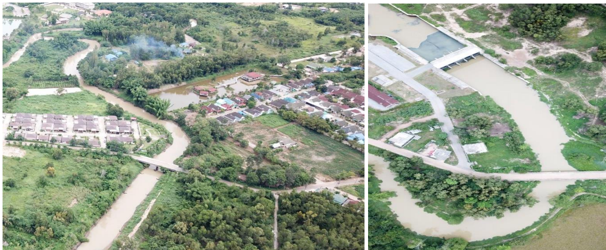
ภาพที่ 5.11 การพัฒนาพื้นที่ตามผังเมืองรวมเมืองระยอง : ก่อสร้างคันกันน้ำท่วมชุมชนเมืองแกลง
