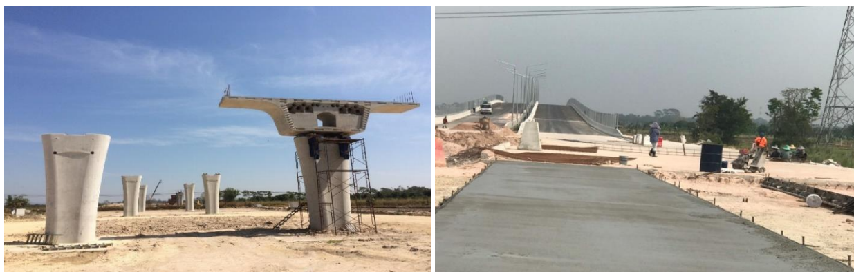
ภาพที่ 1.21 ถนนสายแยกทางหลวงหมายเลข 7 (กม.ที่ 107+200) – ท่าเรือแหลมฉบัง อ.ศรีราชา จ.ชลบุรี (ตอนที่ 4)
