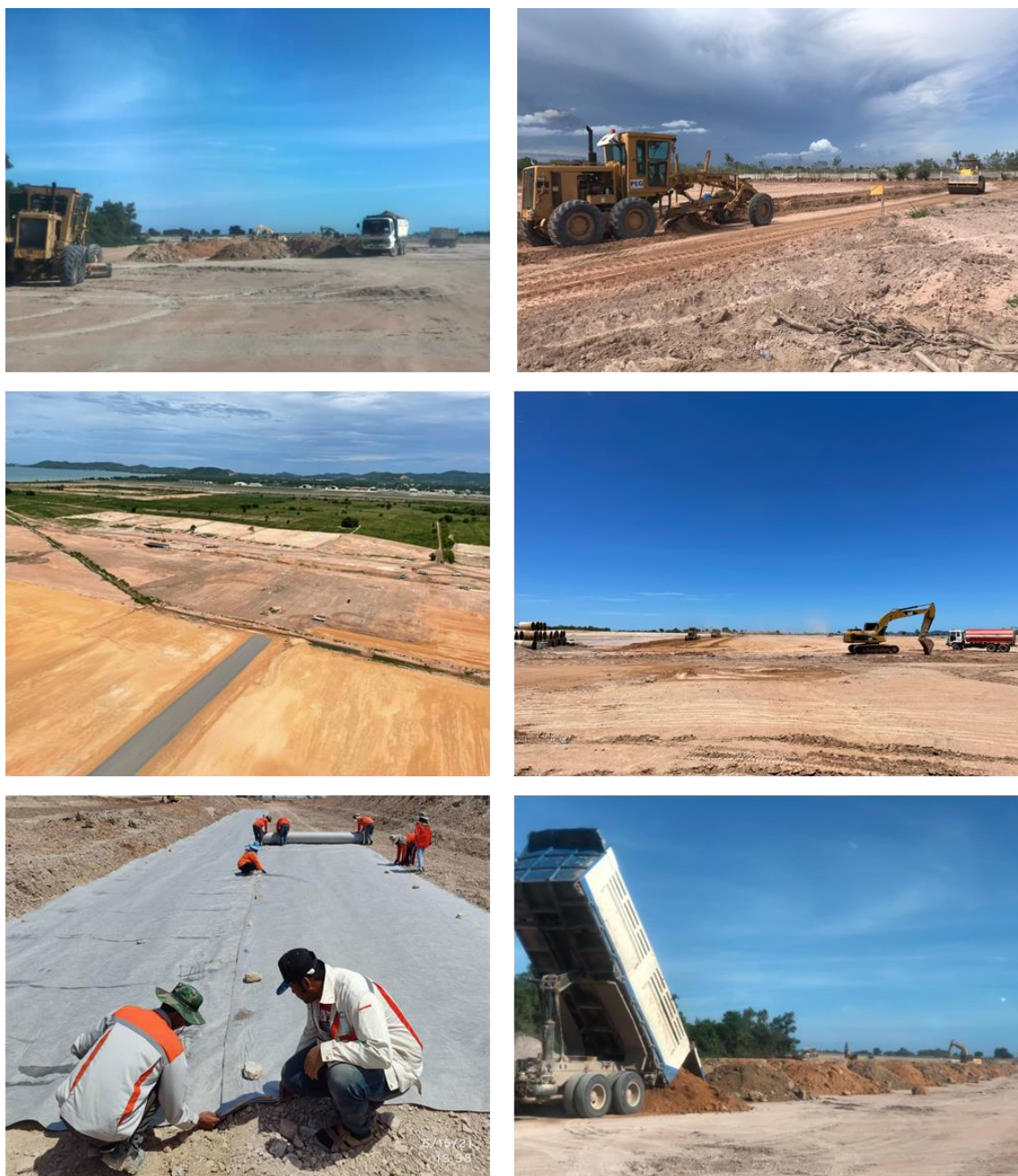
ภาพที่ 1.26 งานปรับพื้นที่ สำหรับก่อสร้างทางชั่วคราวระยะที่ 1 และลานจอดของศูนย์ซ่อมบำรุงอากาศยาน ตำบลพลา อำเภอบ้านฉาง จังหวัดระยอง
