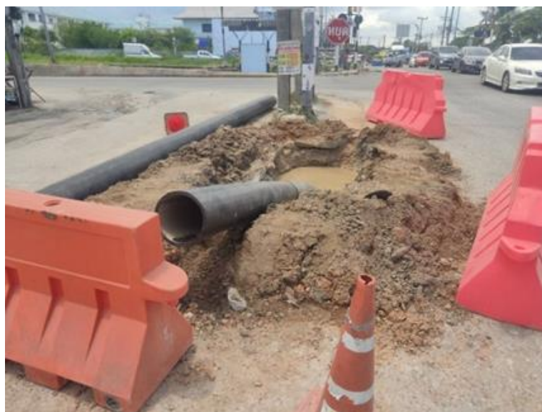
ภาพที่ 1.4 ภาพการเจาะติดตั้งท่อลอดประปาของการประปาส่วนภูมิภาค บริเวณ อ.บางละมุง จ.ชลบุรี
