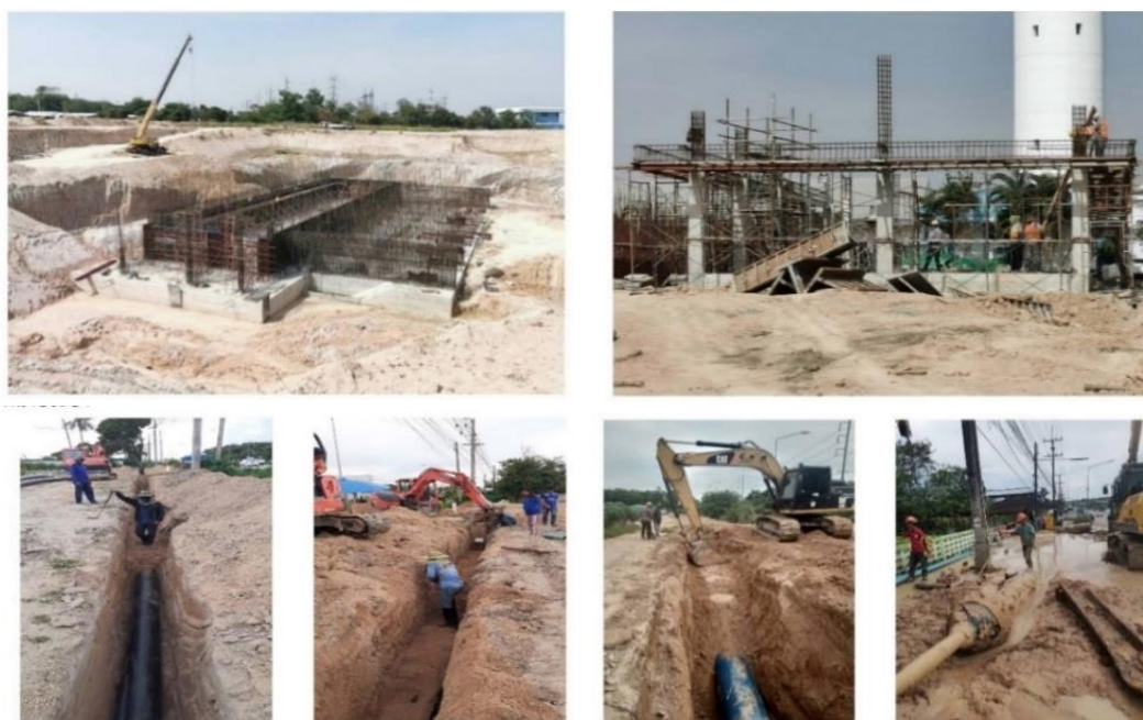
ภาพที่ 1.30 ก่อสร้างปรับปรุงขยาย กปภ.สาขาบ้านฉาง (รองรับ EEC) อำเภอบ้านฉาง-เมืองระยอง-นิคมพัฒนา-ปลวกแดง
