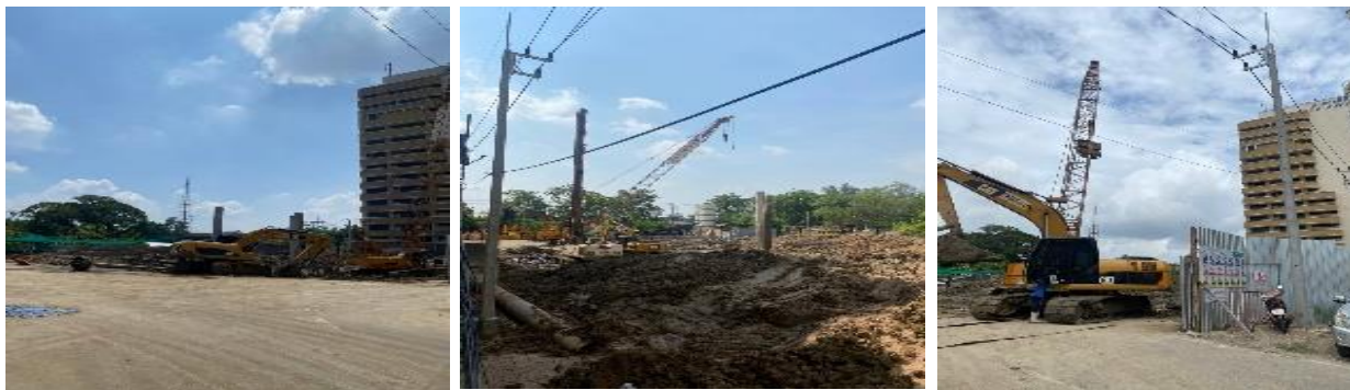
ภาพที่ 5.2 ก่อสร้างอาคารอุบัติเหตุและโรคหัวใจ รพ.พุทธโสธร จ.ฉะเชิงเทรา
