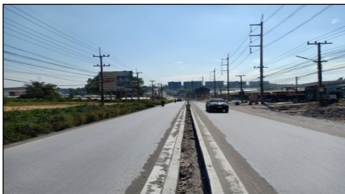
ภาพที่ 10 ถนนสาย รย.3013 แยก ทล.331 - ทล.3191 อ.ปลวกแดง จ.ระยอง
